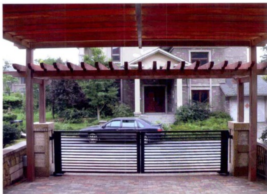
由于标高的关系，出入口棕红色车库花架采取创新设计——整体框架为钢结构，顶部前后双层错落设置，略高的花架顶棚与建筑外墙相连
