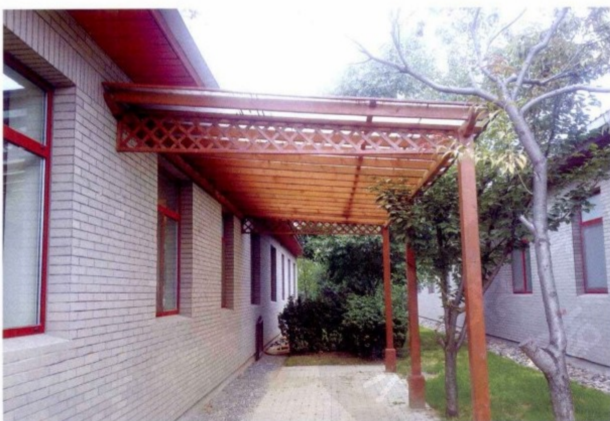
C 木制遮阳棚让一家人多了一处休闲纳凉的好地方
