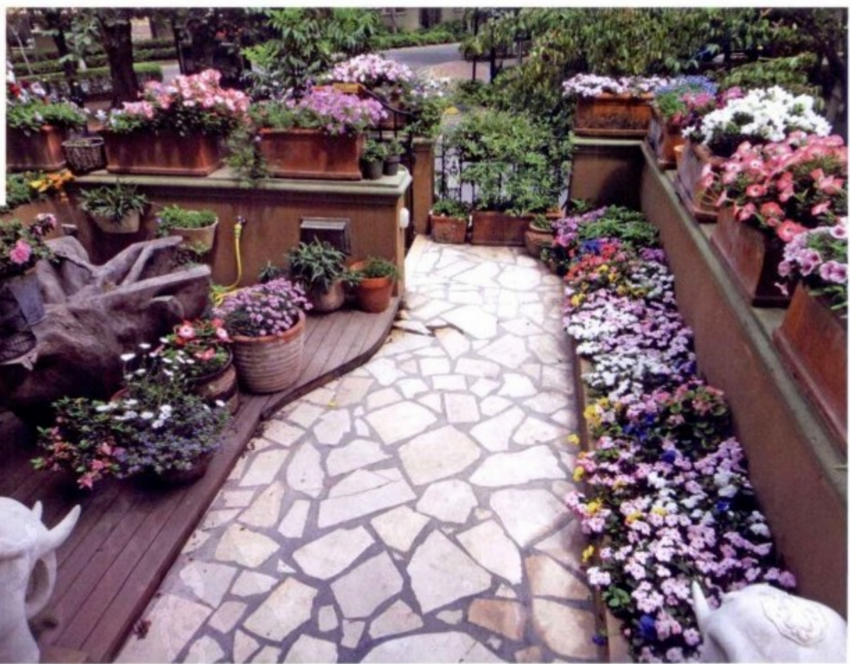
A 室内装修剩下的大理石碎石也被充分利用，成为露台铺地材料
